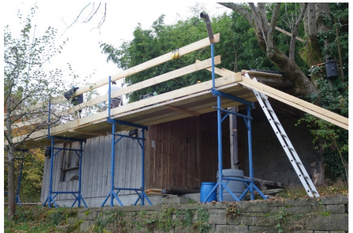
....und der Geräteschopf während der Renovation 2019
